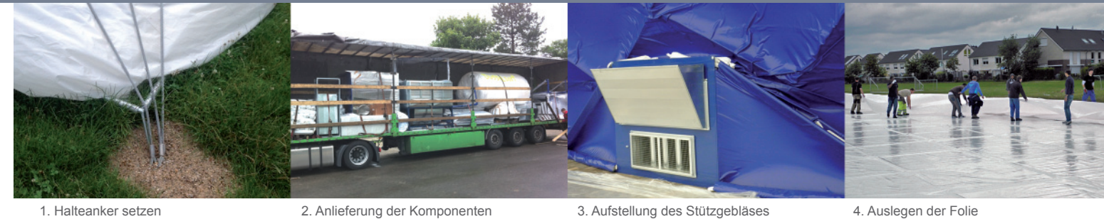
1. Halteanker setzen
