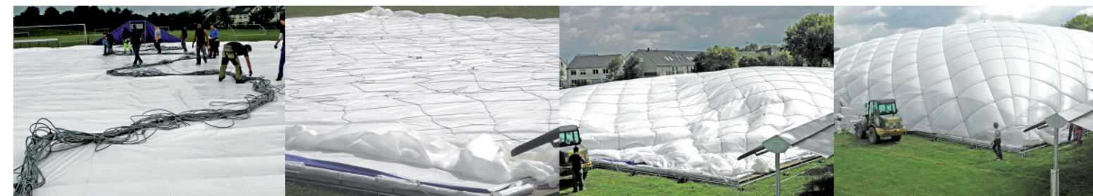
5. Positionieren des Seilnetzes
